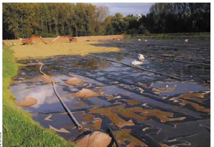
Op de met draineerbuizen voorziene folie van de uitlekzone wordt een laag zand aangebracht.
