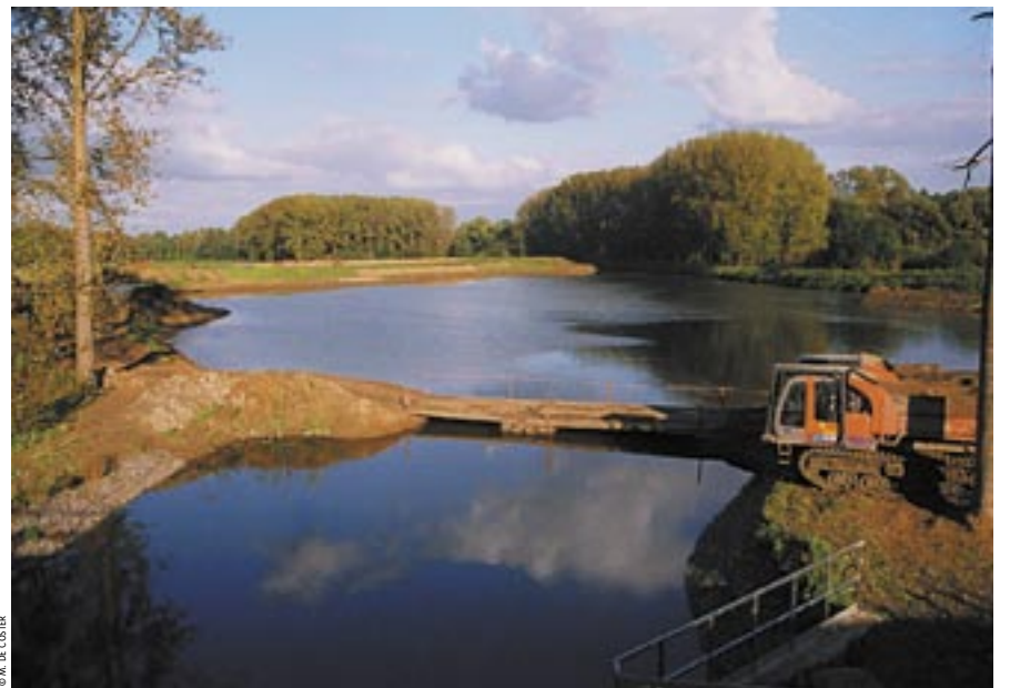
Zandvang aan de rand van Egenhovenbos, na de nieuwe stuw op de Dijle.
